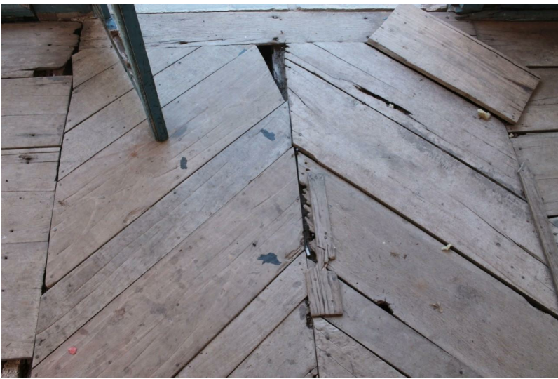
Figura 179 - Piso de madeira tabuada da varanda em frente à edificação, bem degradado e com várias partes faltantes e quebradas. Além disso, há presença de algumas emendas e tabuas soltas. Todas podem ser visualizadas através das setas e retângulos vermelhos. Foto: SECULT - Isabella Alves, 19/01/2022.
