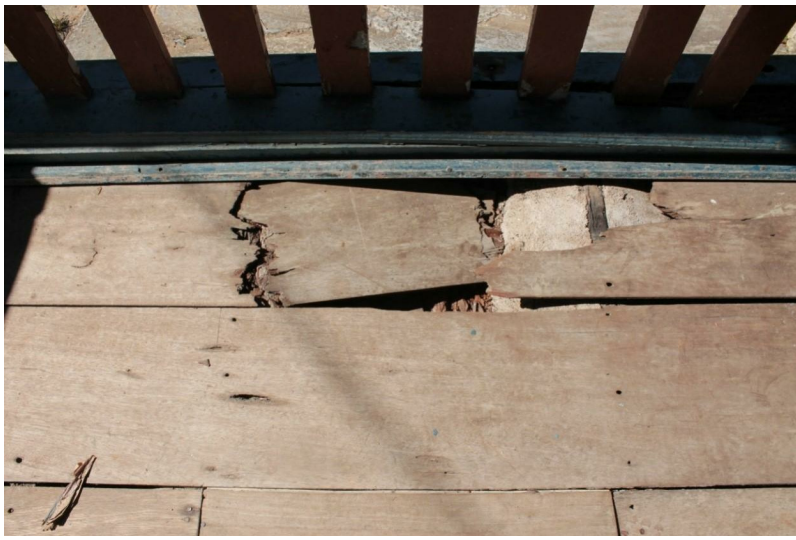
Figura 180 - Piso de madeira tabuada da varanda em frente a edificação com parte quebrada e faltantes visualizada através do retângulo vermelho. - Fazenda Boa Esperança. Foto: SECULT - Isabella Alves, 19/01/2022.
