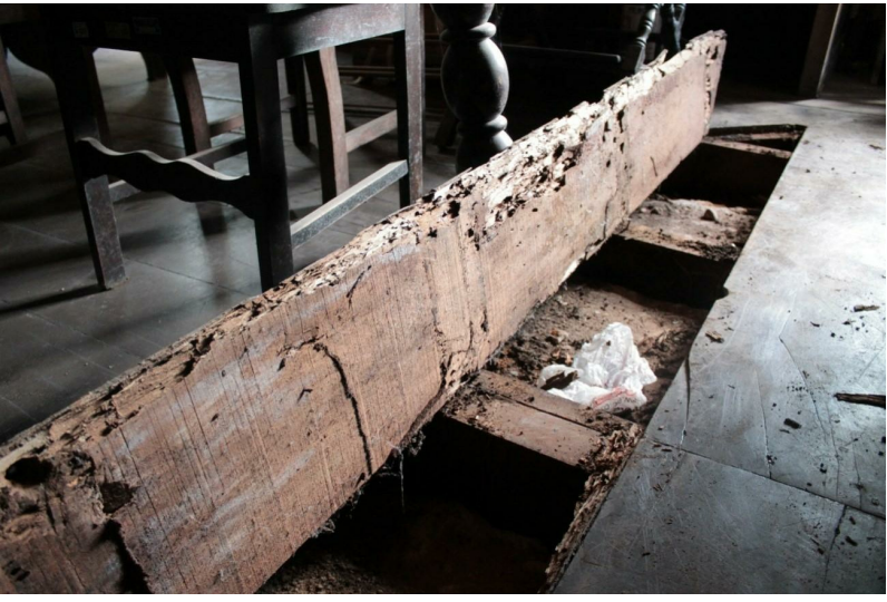
Figura 190 – Análise do desprendimento de uma peça do piso de madeira do salão principal (Sala 13), com presença de galerias de insetos xilófaga bem comprometida. Abaixo se identificou a presença de piso em concreto entre os barroteamentos. Foto: SECULT - Brenda Souza, 16/03/2022.
